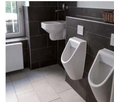
Das komplett renovierte Herren-WC
