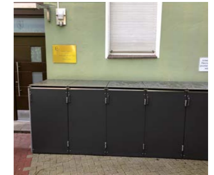
Neue Einhausung der Mülltonnen
