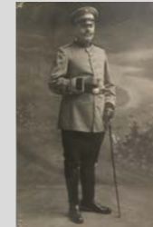
1919 Firmengründung durch Oberingenieur Hans Rückert in Dresden.
