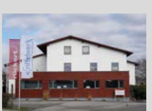
2018 Modernisierung und Ausbau von Büroräumen und Werkstatt
