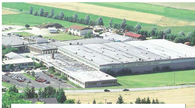
Firmsitz der Schmidt-Seeger AG (Hauptwerk) vor dem altersbedingten Verkauf. Später übernommen durch die Fa. BÜHLER GmbH – Grain Quality & Supply.
