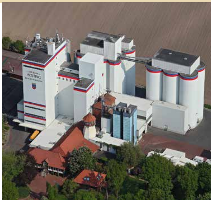
Luftaufnahme Austing Mischfutterwerk GmbH &amp; Co. KG
